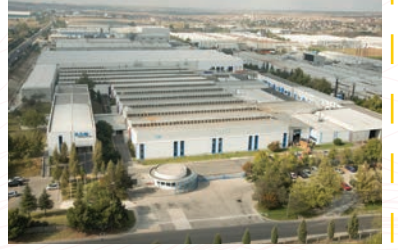
DANFOS ÇERKEZKÖY FACILITY
